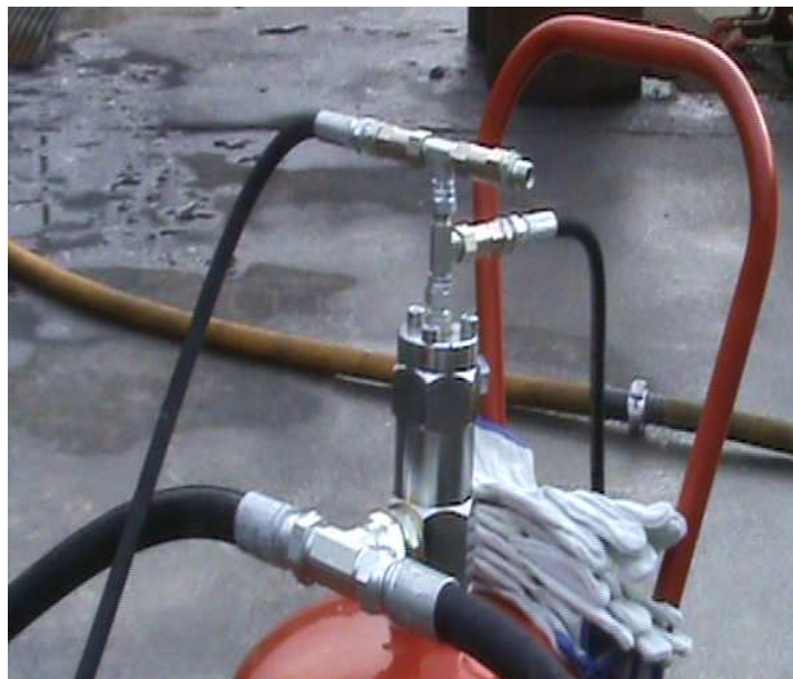
Figura 7: Conexiones instaladas en el recipiente
