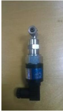
**Presostato de señalización de maniobra para sistema FIRE-TEX-ES**
