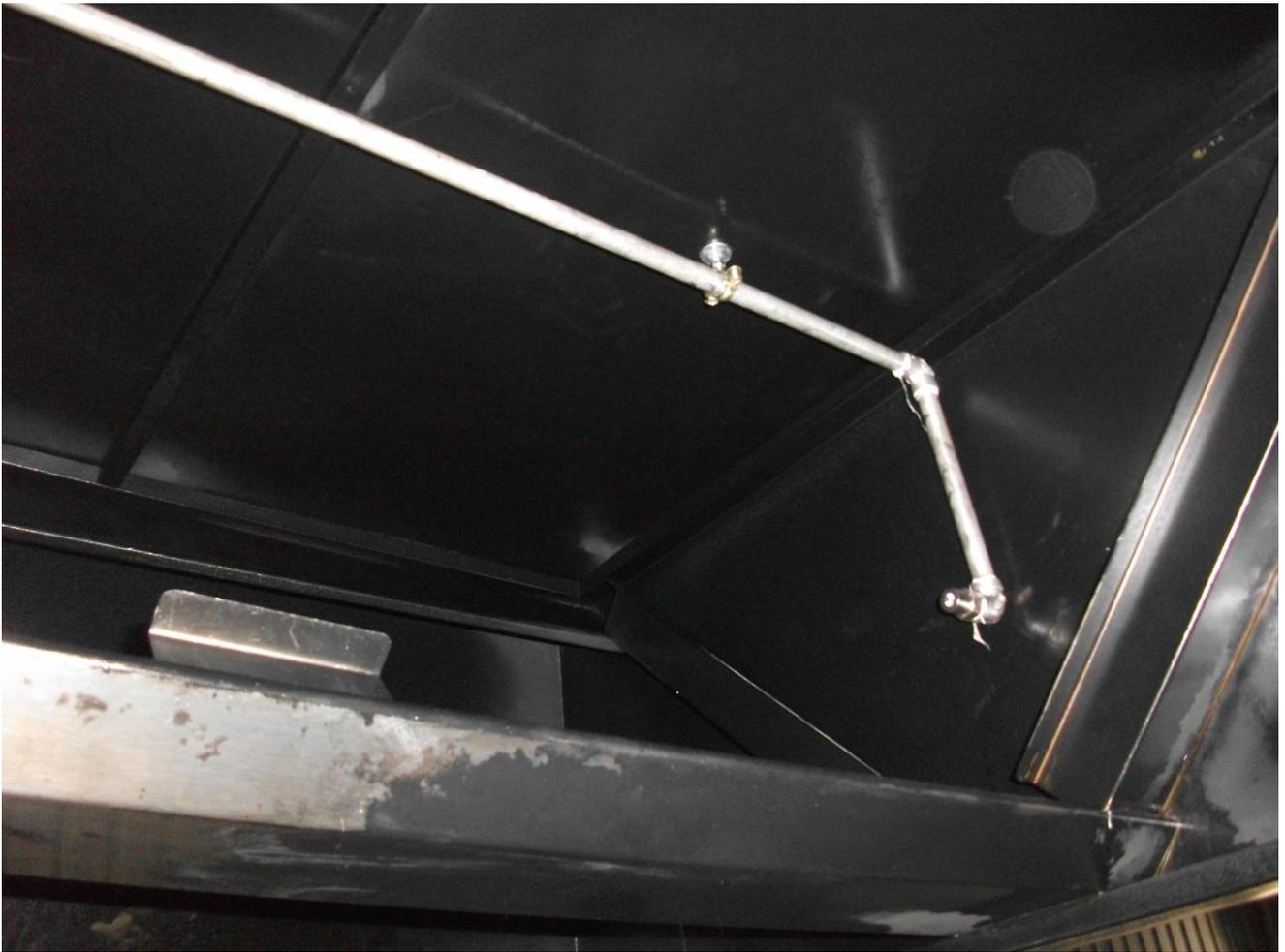
**Fig. 5: Detalle final línea central con boquilla de descarga hacia interior de filtros**
