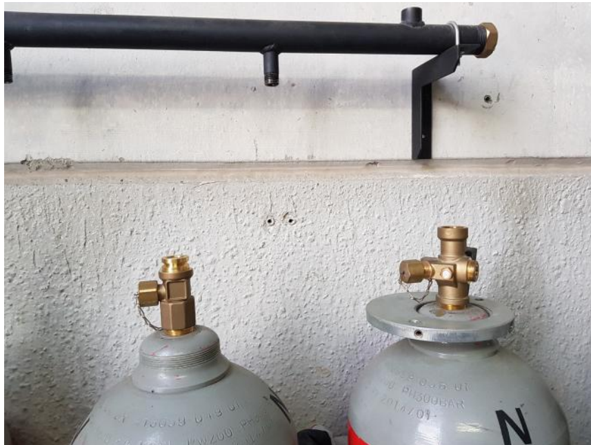
Fotografía de colector y tapon de colector con las escuadras y abarcones de sujeción.
