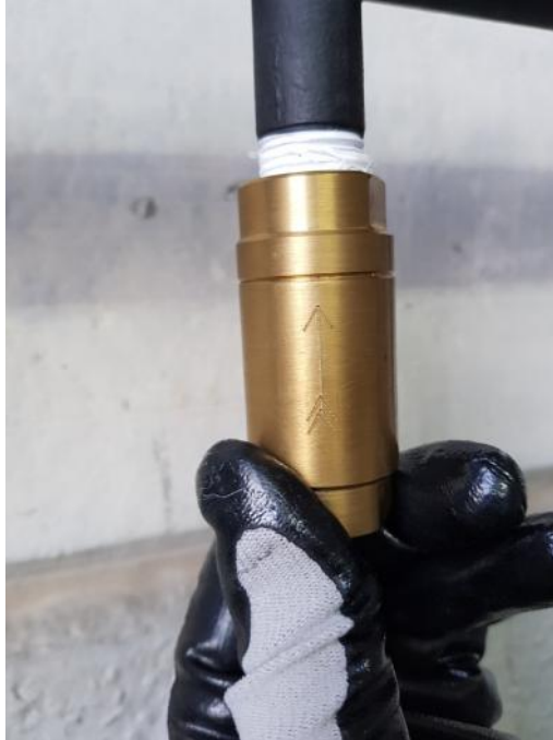
Fotografía de colocacion manual de válvula de retencion al colector. (flecha siempre hacia arriba)
