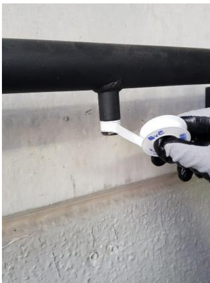
Fotografía de preparación roscas colector para válvulas de retencion.
