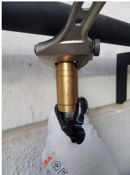
Fotografía de apriete de válvula de retencion con llave fija al colector
