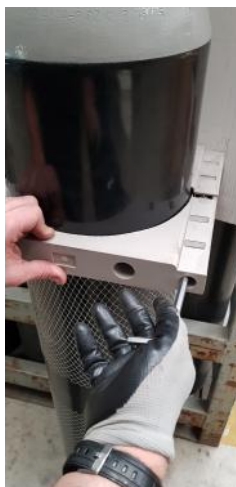
Fotografía de sujeción del cilindro al herraje y el herraje a la pared.
