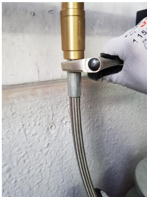
Fotografía de apriete de válvula de retención al latiguillo de disparo del cilindro
