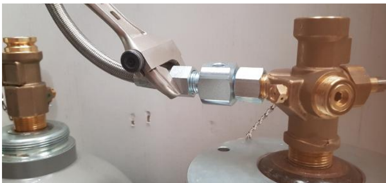
Fotografía de colocacion de latiguillo de disparo sobre el desviador neumatico de pilotaje
