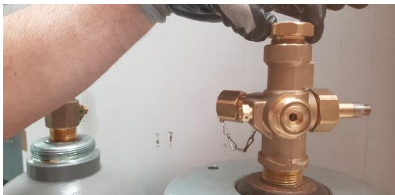
Fotografía de cómo quitar la tapa superior de la válvula piloto
