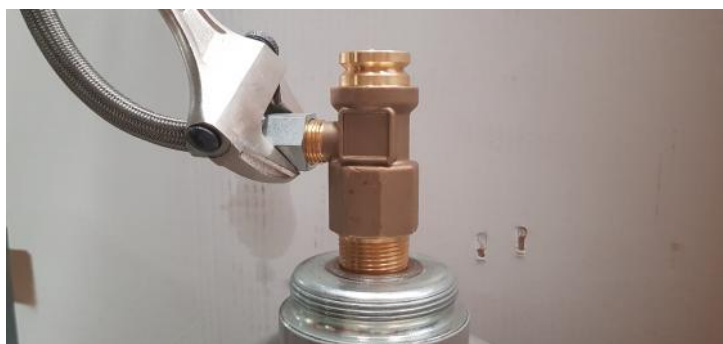
Fotografía de cómo conectar latiguillo de disparo a la boca de salida de válvula auxiliar
