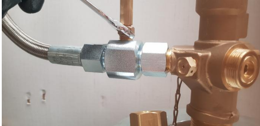
Fotografía de cómo conectar latiguillo de pilotaje a desviador neumático en válvula piloto
