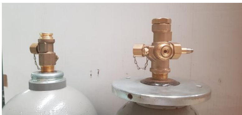
Fotografía de cómo se reciben las válvulas piloto y auxiliar
