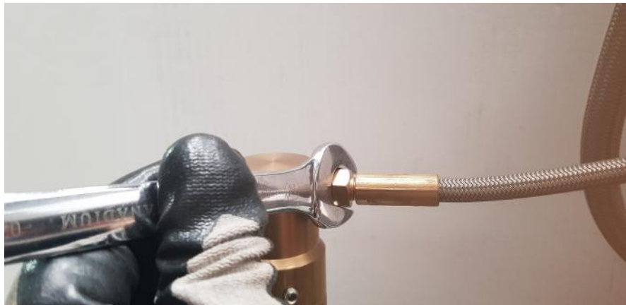
Fotografía de cómo conectar el latiguillo que viene del desviador neumático de la válvula piloto al cabezal neumático de la primera válvula auxiliar de la batería
