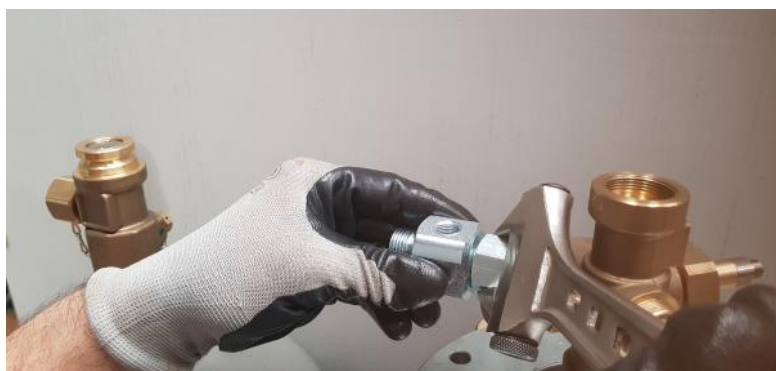
Fotografía de cómo colocar el desviador neumatico a la boca de salida de la válvula piloto
