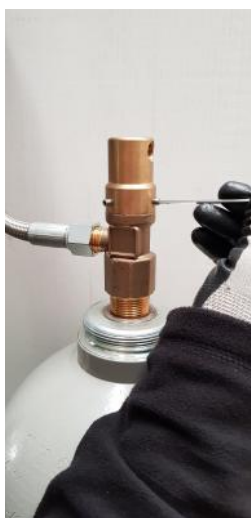
Fotografía de cómo colocar el cabezal neumático de pilotaje en la válvula.
