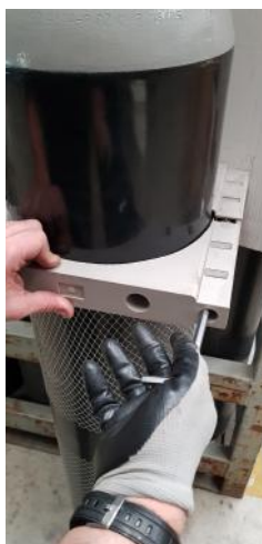
Fotografía de sujeción del cilindro al herraje y el herraje a la pared.
