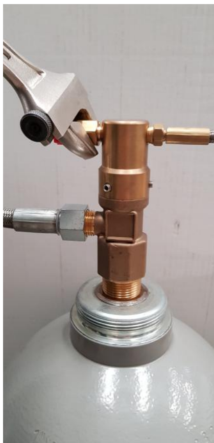
Fotografía de cómo instalar el tapon final de línea de pilotaje con venteo
