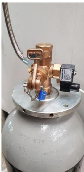
*Fotografía de válvula totalmente montada y operativa.*
