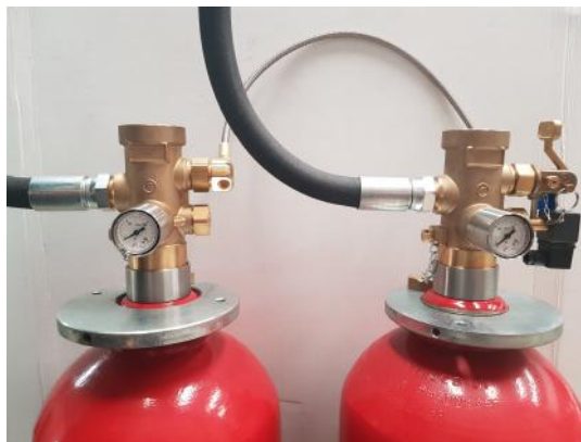
Fotografía de cómo queda el latiguillo de pilotaje desde cilindro piloto a primer cilindro auxiliar.
