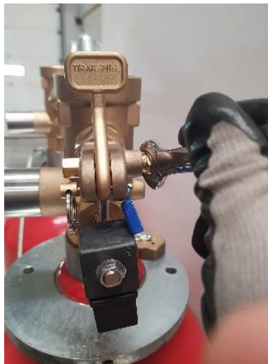
Fotografía de cómo se aprieta con llave fija el latiguillo de pilotaje en la valvula piloto
