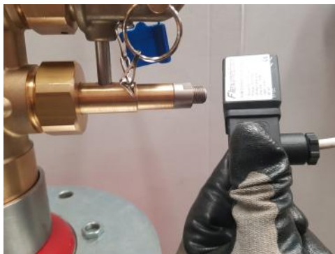
Fotografía de colocación de la bobina electroiman en la solenoide de la válvula.
