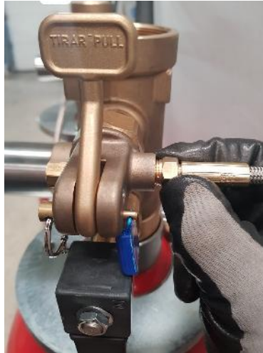
Fotografía de cómo se rosca manualmente el latiguillo de pilotaje en la valvula piloto desde del desviador neumático.
