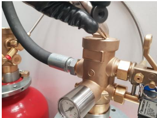
Fotografía de cómo apretar con llave la tapa superior de la válvula piloto anteriormente quitada.
