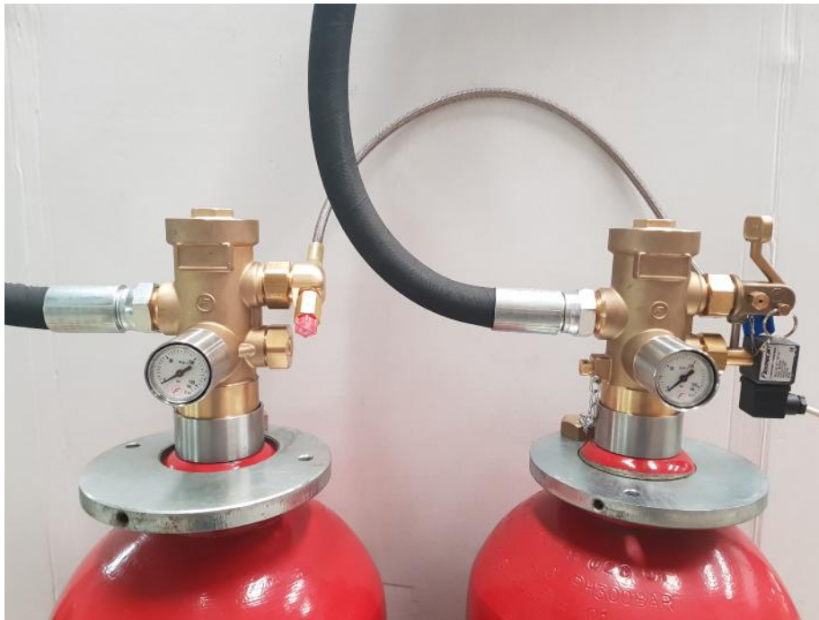
Fotografía de válvulas totalmente montadas y operativas.
