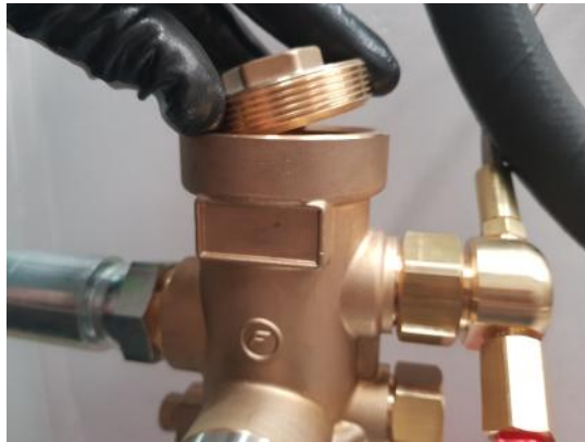
Fotografía de cómo roscar manualmente la tapa superior de la válvula auxiliar anteriormente quitada.
