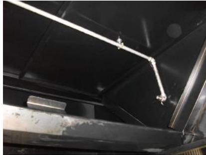
Ejemplo gráfico de instalacion de difusor en el centro de la parte de plenum o filtros internos. A su vez se aprecia la instalacion del ramal que accede al conducto de extracción y la colocacion del primer de los 2 difusores que van en el conducto de extracción. El difusor a montar en el medio del plenum ha de estar a maxima altura dentro del plenum y orientado a 90° respecto al suelo.
