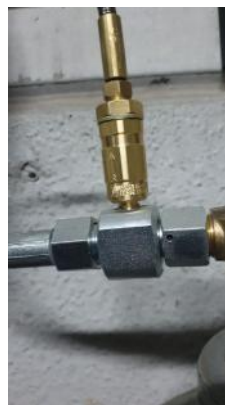
Fotografía fijación con llave de válvula antirretorno y latiguillo de pilotaje de 1/4" que va desde el cilindro piloto al primer cilindro auxiliar.
