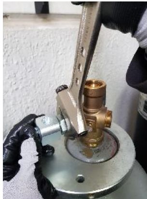
Fotografía fijación con llave de desviador neumático válvula piloto en boca de salida del gas.
