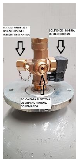
Fotografía de puertos de la válvula.
