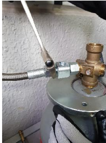
Fotografía fijación con llave de latiguillo de disparo de 1/2" que va al colector de disparo
