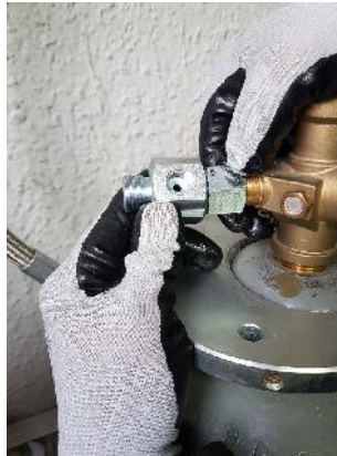
Fotografía colocación manual de desviador neumático válvula piloto en boca de salida del gas.
