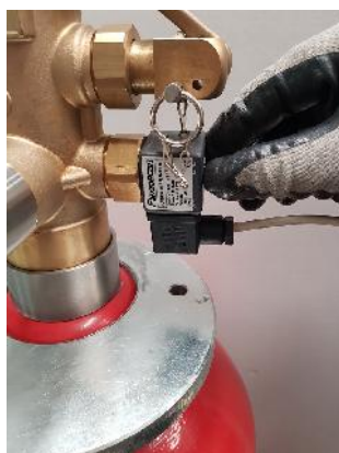
Fotografía de colocación de la bobina conectada en la solenoide de la válvula.
