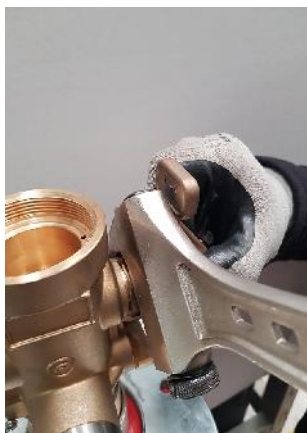
Fotografía de cómo apretar con llave el sistema de disparo a su correspondiente puerto en la válvula.
