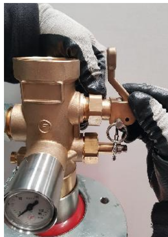
Fotografía de cómo roscar el disparo manual al puerto correspondiente en la válvula.
