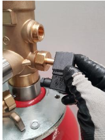
Fotografía de cómo quitar la tuerca de la bobina electroimán de la válvula.
