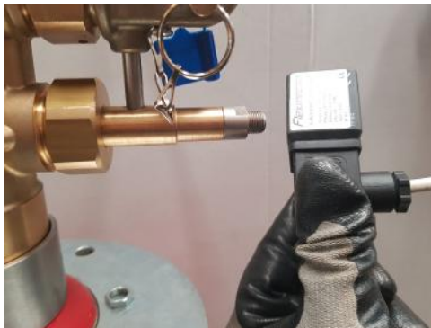
Fotografía de colocación de la bobina electroiman en la solenoide de la válvula.
