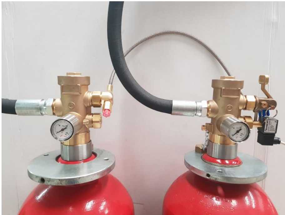
Fotografía de válvulas totalmente montadas y operativas.
