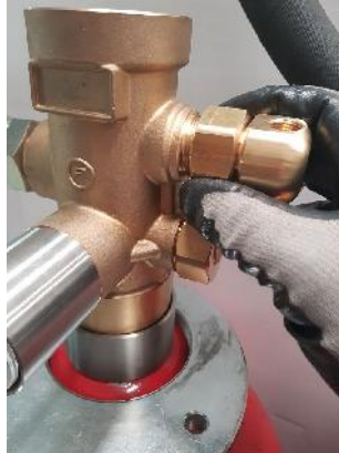
Fotografía de cómo se rosca manualmente el cono de pilotaje en la valvula auxiliar.
