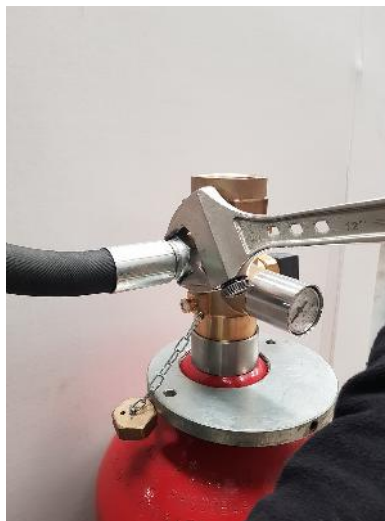
Fotografía de cómo apretar con llave el latiguillo de salida de gas a la boca de salida de gas.
