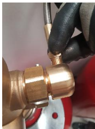
Fotografía de cómo se rosca manualmente el latiguillo de pilotaje en el cono de pilotaje de la valvula auxiliar.
