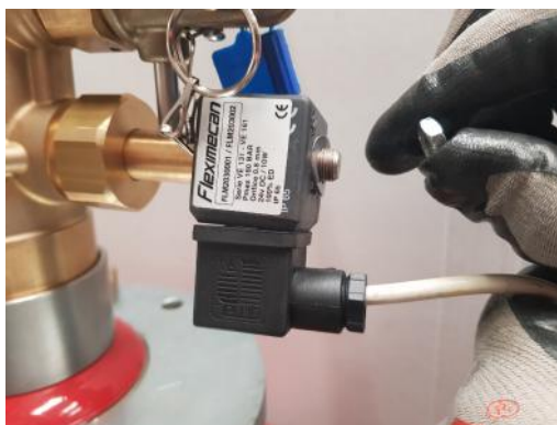
Fotografía de colocación de la tuerca de la bobina conectada en la solenoide de la válvula.
